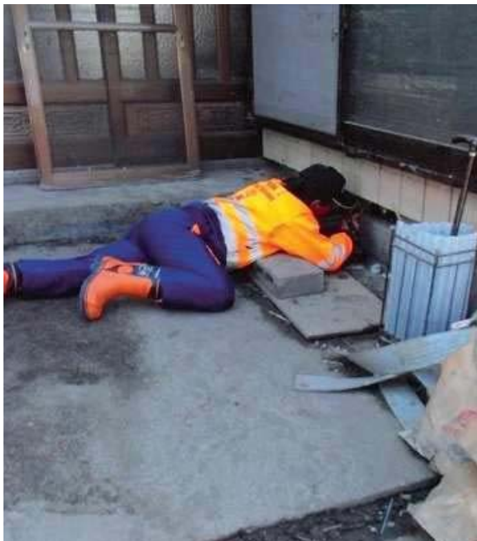
通風口から床下の泥を確認する
