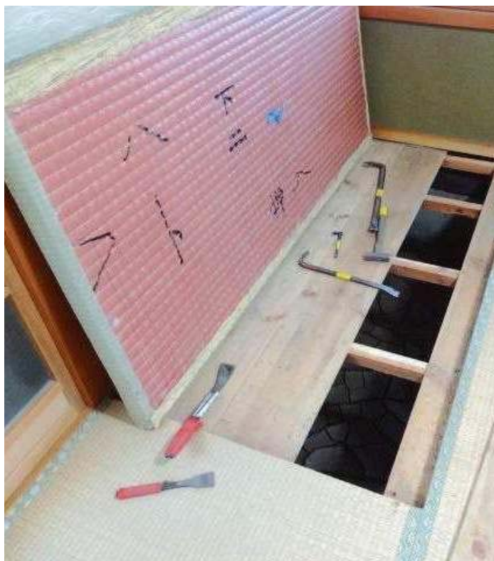
和室の床板をはがす（写真①）
