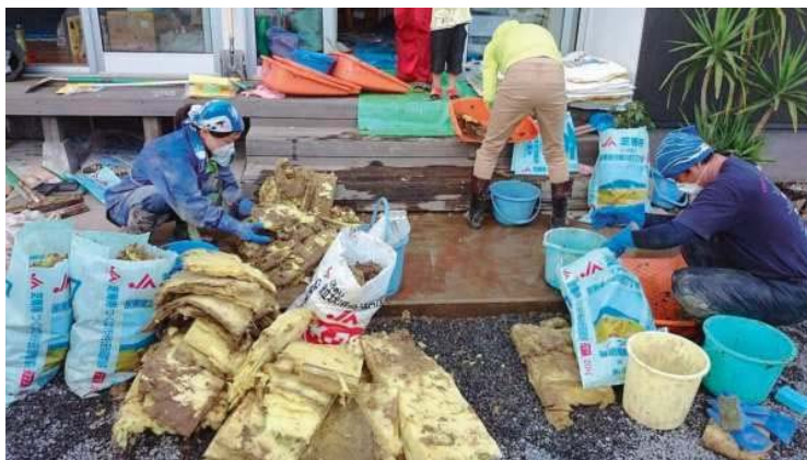
↑ 断熱材の取出し
